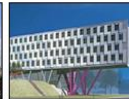
LBBW Verwaltungsgebäude, Karlsruhe
