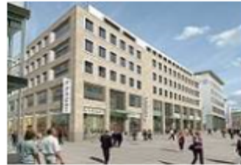
LBBW Kronprinzbau, Stuttgart
