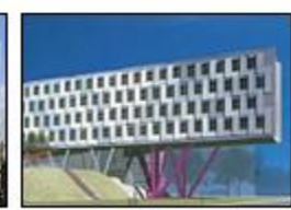
LBBW Verwaltungsgebäude, Karlsruhe
